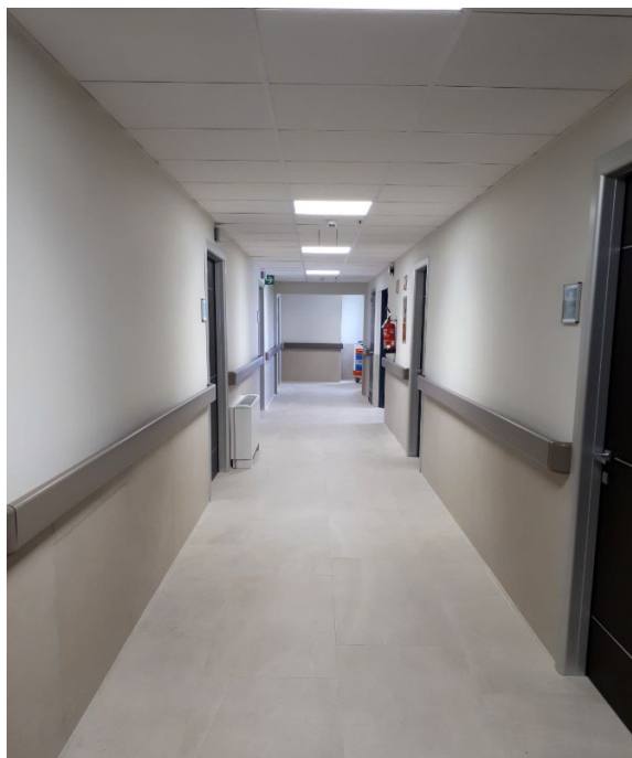
Figur. Esempio di corridoio realizzato con le finiture previste dal progetto: gres a pavimento e a parete, fascia corrimano e paracolpi, smalto a parete e controsoffitto
