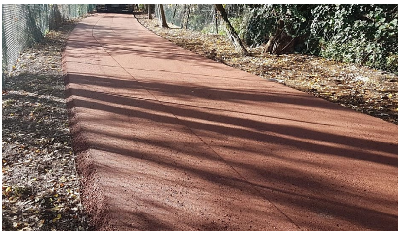
Figura 8. Esempio di pavimentazione in calcestruzzo drenante
