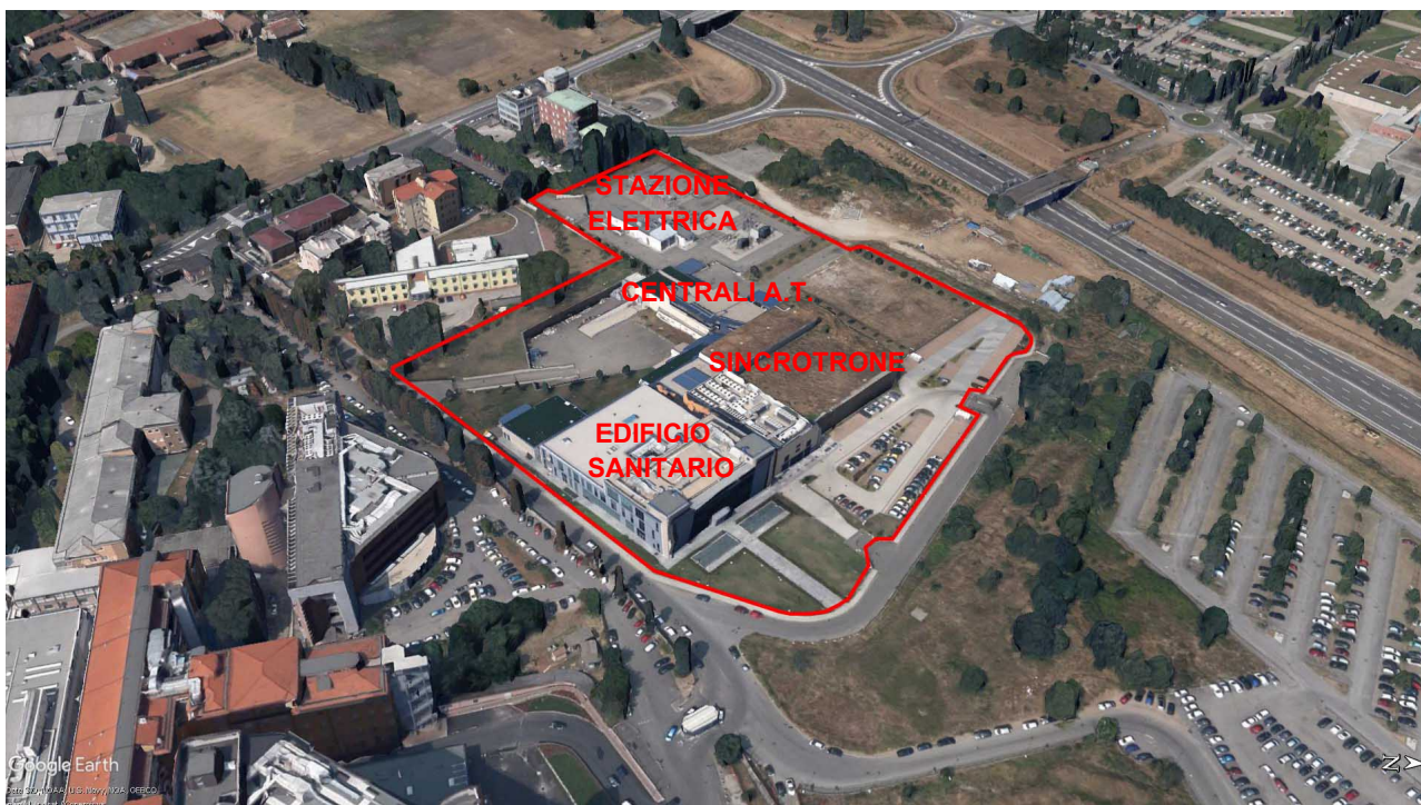
Figura 1. Veduta aerea del CNAO
